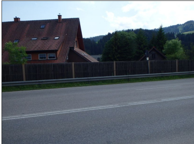
Bestehende Lärmschutzwand in Breitnau
